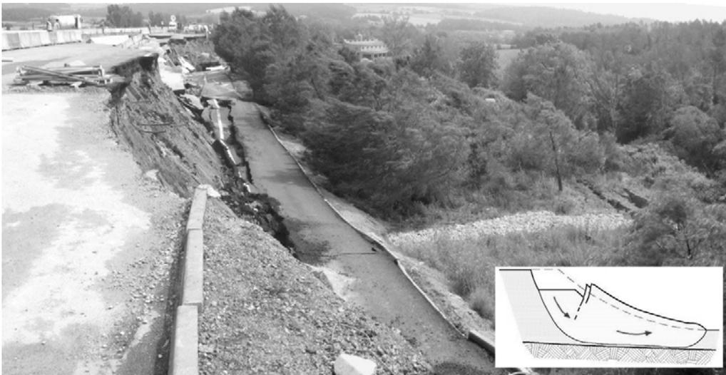
**Fotografía 2:** Panorámica parcial del deslizamiento y esquema de forma de rotura (el pie queda a la derecha, fuera de la fotografía).
