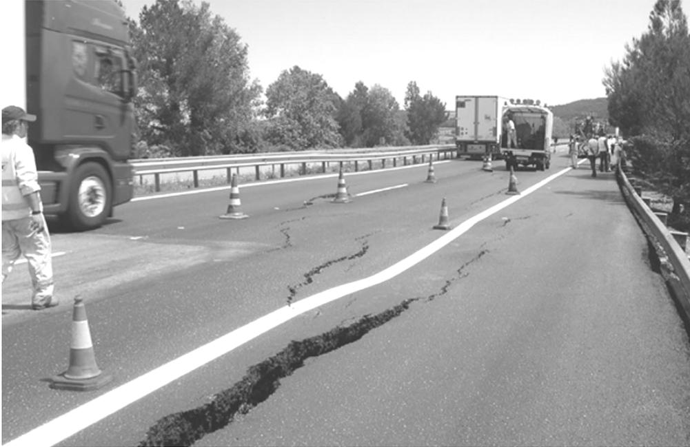
**Fotografía 1:** Grietas y escalones previos a la rotura completa
